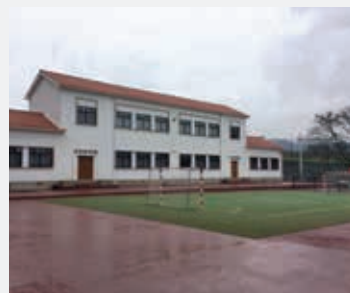
Recreio após intervenção exterior
