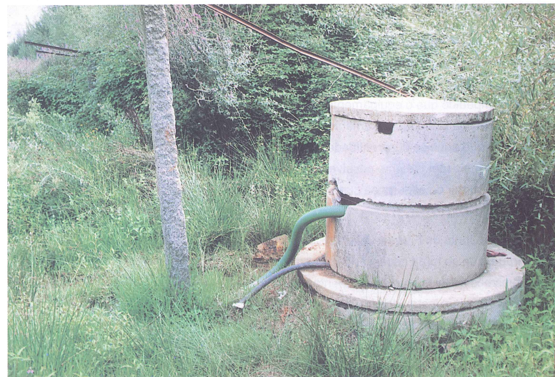
Poços inquinados vão ser "substituídos" pela água canalizada
