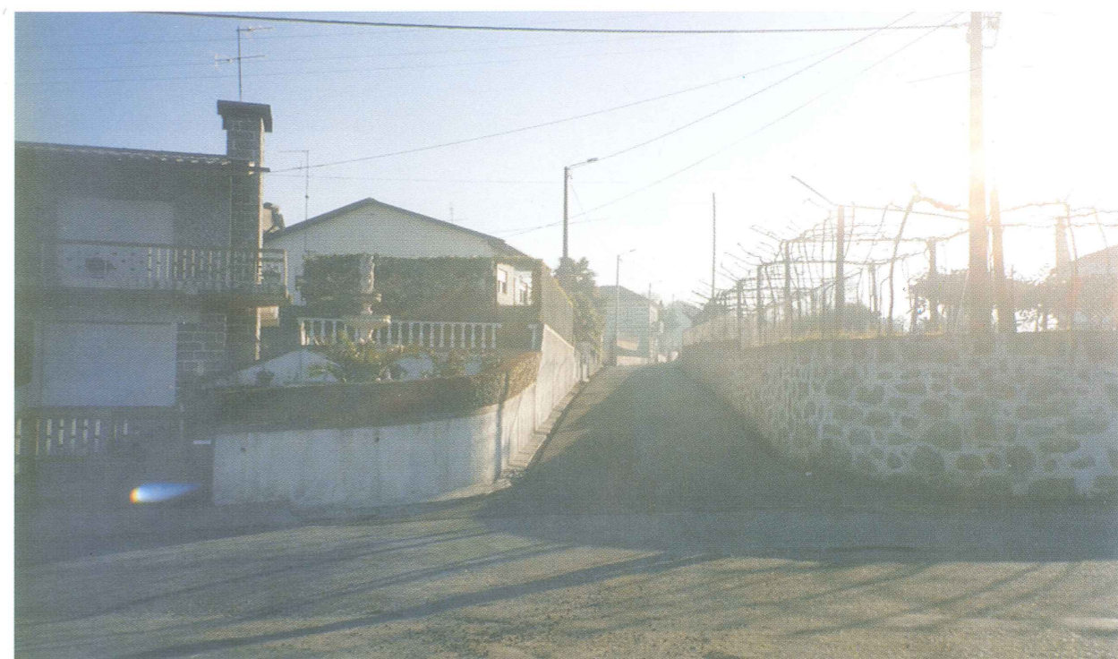
Mais duas obras concluídas. Mais moradores com condições condignas.
