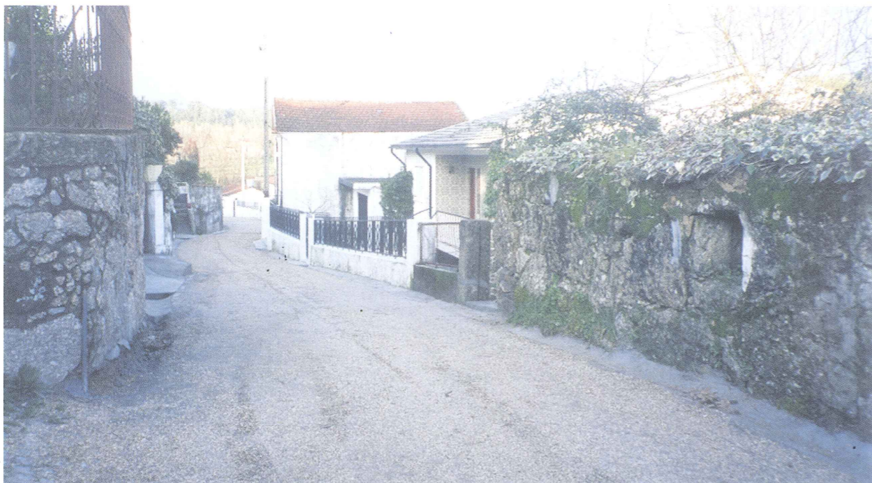
A rua depois das obras concluídas. Agora, aqueles moradores podem chamar um taxi, uma ambulância, etc.. A qualidade da obra justifica a sua visita ao local
