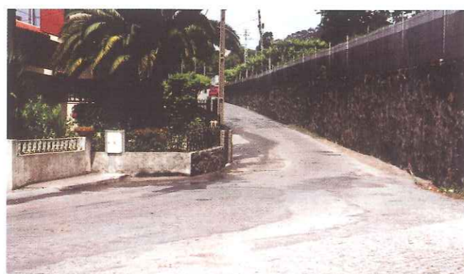
Conclusão da Rua do Gavião Real vai ser mesmo real.
