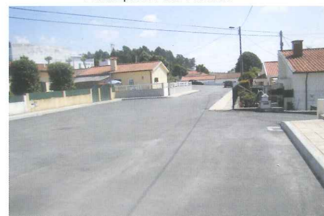
Pavimentação da Rua D. Afonso II
