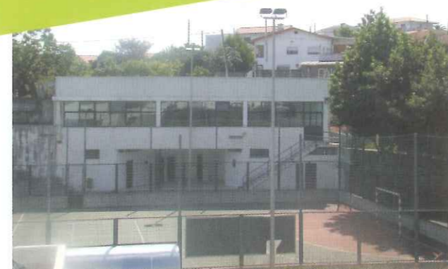
Drenagem de águas pluviais no lado poente do Polidesportivo das Ribeiras
