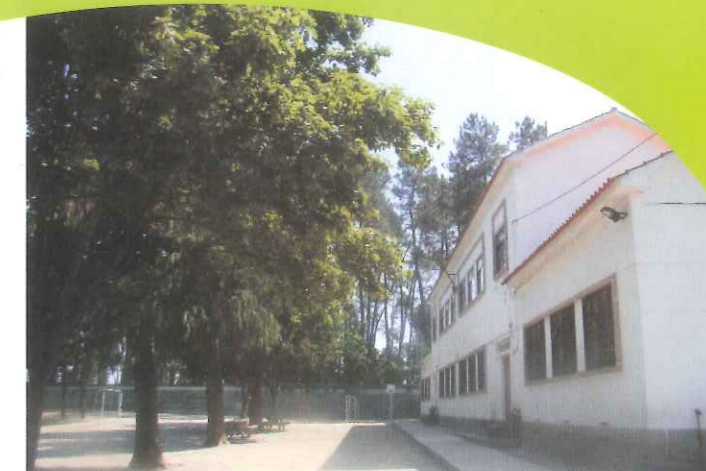
Drenagem de águas pluviais no recreio da Escola
